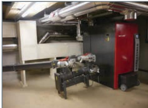
Chaudière de 200 kW avec 2 vis entrée chaudière
