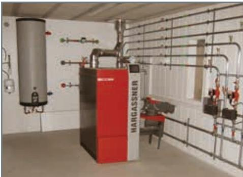
Chaudière EcoHK de 35 kW avec Production d'ECS
